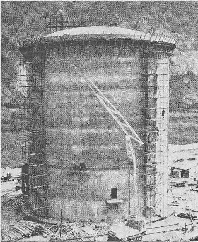
Bild 6. Silo samt Kuppeldach betoniert. Vor den 4 Lisenen stehen die Rohrgerüste als Arbeitsbühnen für das Spannen der Vorspannbewehrung
