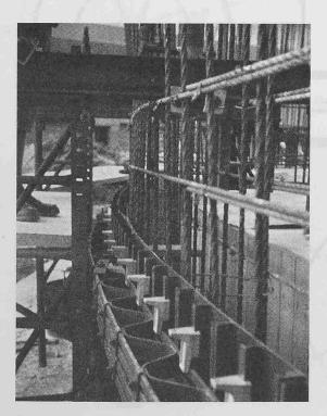
Bild 4 (links). Gleitschalung mit horizontalem Versteifungsträger und Hebehock
