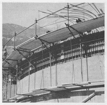
Bild 3. Aussenschalung des Silo-Mantels mit Gerüst und Hängebühne
