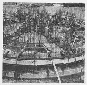
Bild 2. Gleitschalung des Silo-Erdgeschosses
