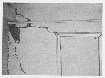
Bild 2. Typische Schäden an sekundären Bauelementen (Photo Dean)
