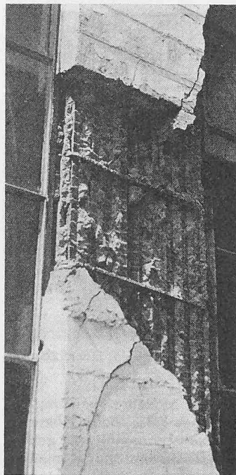
Bild 7 (links). Schaden infolge schlechter konstruktiver Ausführung: Eisenabstand, Betonierfuge, Betonüberdeckung. (Photo Engle)
