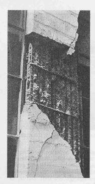
Bild 7 (links). Schaden infolge schlechter konstruktiver Ausführung: Eisenabstand, Betonierfuge, Betonüberdeckung. (Photo Engle)
