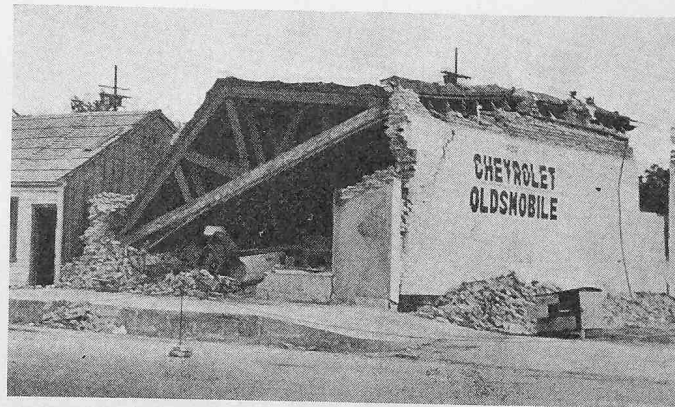
Bild 13. Tehachapi, Cal., 1952: Typische Mauerwerkschäden (Photo Degenkolb)
