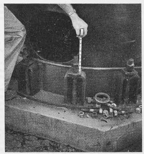
Bild 16. Ueberstreckte Ankerschrauben eines Cracking-Turmes in einer Raffinerie; Masstab in Zoll. (Photo C. F. Braun & Co.)
