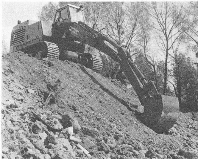
Hydrobagger Poclair TC 45 auf Raupen, vollkommen hydraulisch gesteuert, kann um 360° drehen. Tieflöffel 0,85 m breit, 0,3 m 3 Inhalt.
