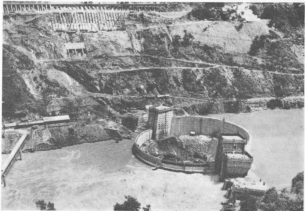
Die zweite Baugrubenumschliessung am 27. Januar 1958
