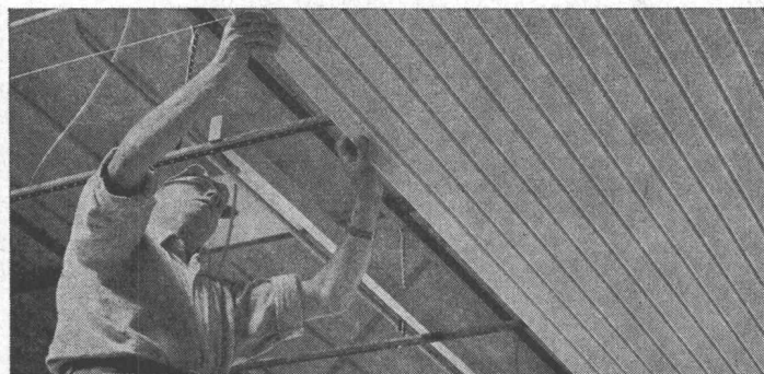
DAMPA Metalldeckenpaneele, demontierbar in Akustik- und Ventilationsdecken
