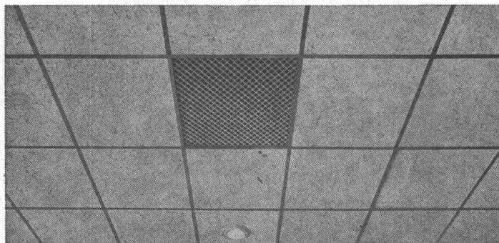
ULTRACOUSTIC Schallschluckplatte, ungelocht, unbrennbar, hier in Hängeroost
