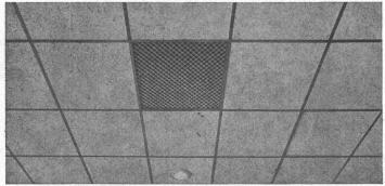
ULTRACOUSTIC Schallschluckplatte, ungelocht, unbrennbar, hier in Hängerost
