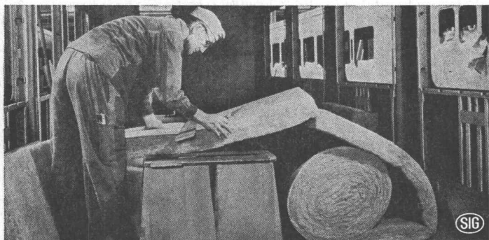
ULTRALITE Isoliermatte, langfaserig, erschütterungsfest und unbrennbar
