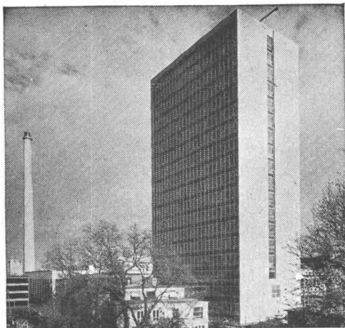
Im Hochbau für hohe Festigkeiten
