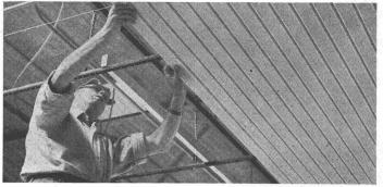
Metalldeckenpaneele, demontierbar in Akustik- und Ventilationsdecken
