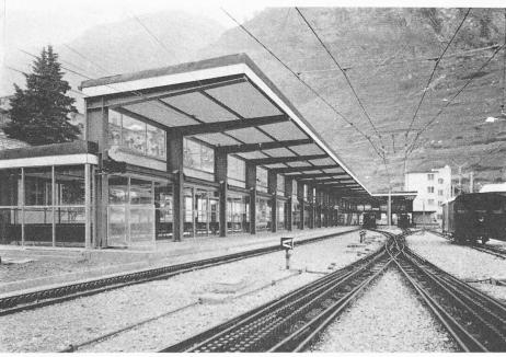
Bild 16. Das auskragende Bahnsteigdach
