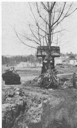
Verpflanzung grosser Bäume mit Hilfe eines dafür hergerichteten Schaufelladers
