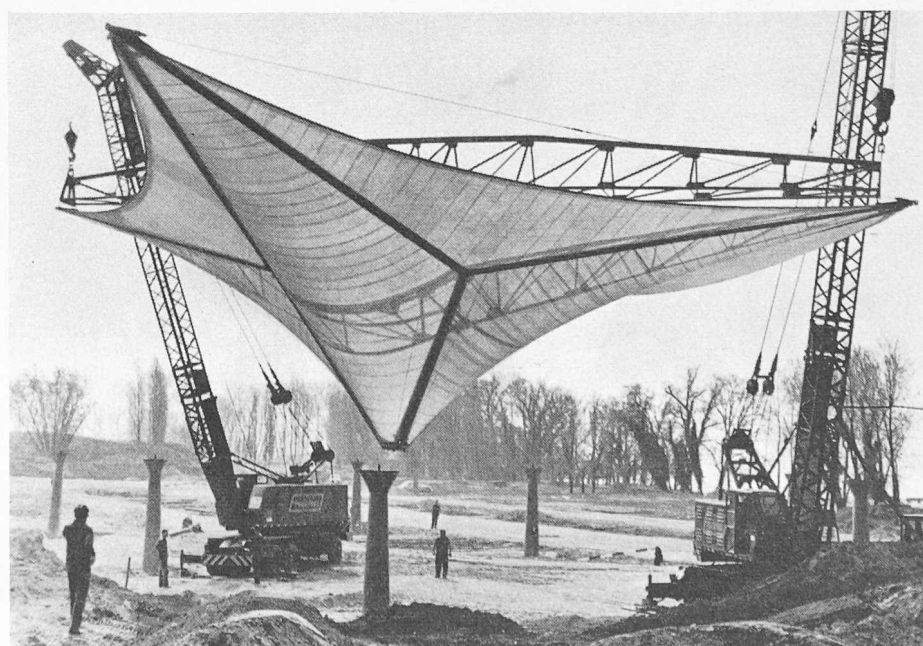
Bild 3 (oben). Modellversuch an einer Einheit im Massstab 1:6
