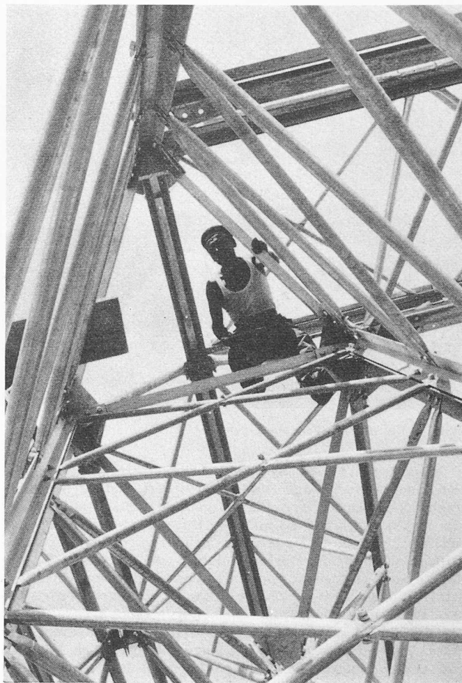
Bild 9. Innenbild einer Rahmenecke, das die konstruktive Ausbildung (Anschluss der Rohrstreben und Windverbände an die Gurtungen) zeigt.
