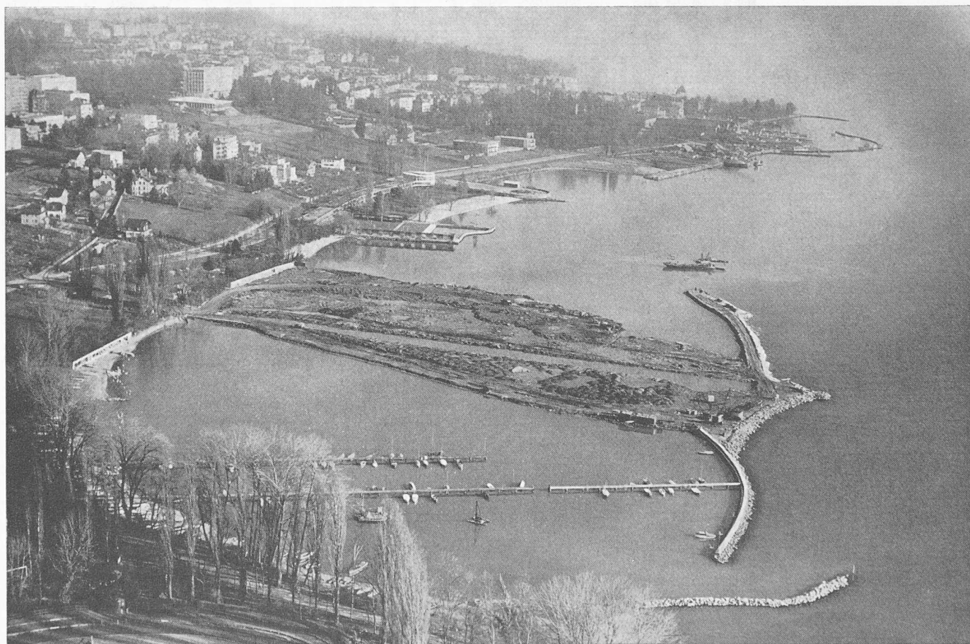
Bild 2. Stand der Arbeiten am 1. Februar 1960, aus Westen. Im Vordergrund der alte Hafen von Vidy, dahinter die Auffüllung, geschützt durch die neue Mole und den neu geschütteten Strand. Der in der Auffüllung offen gelassene Graben ist bestimmt für einen Entlastungskanal für Gewitterregen
