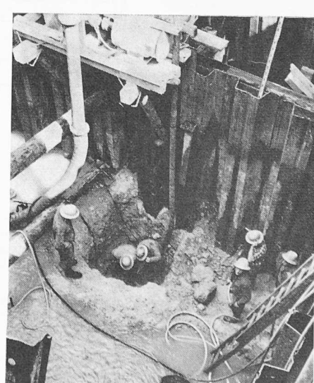
Bild 13. Mittelpfeiler, Erstellung des Entwässerungsschachtes, 17. April 1963
