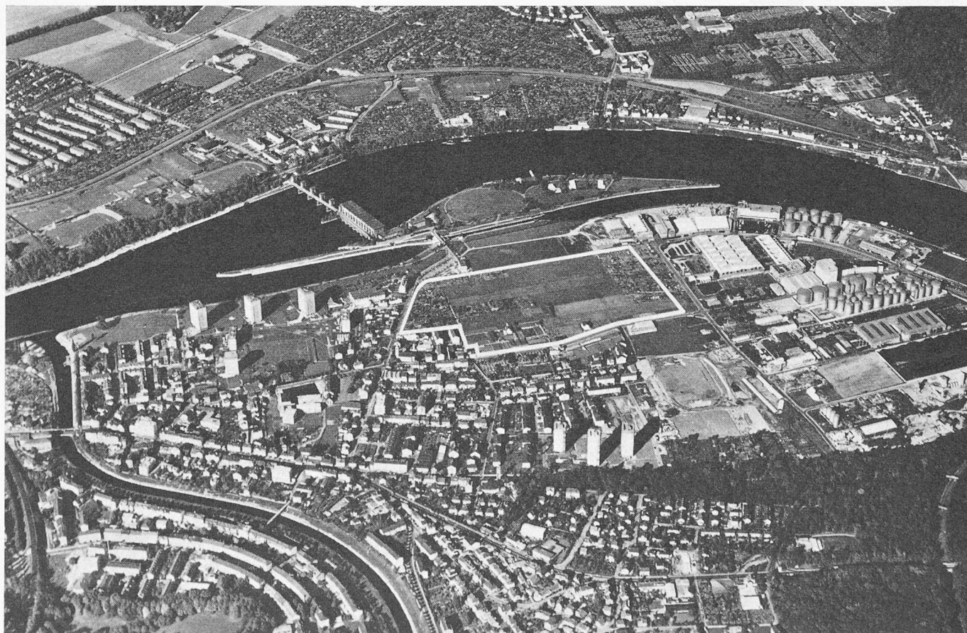
Luftaufnahme des Sternfeldes in Birsfelden, Oben links das Kraftwerk, Weiss umrandet das Wettbewerbsgebiet, Phot. Balair
