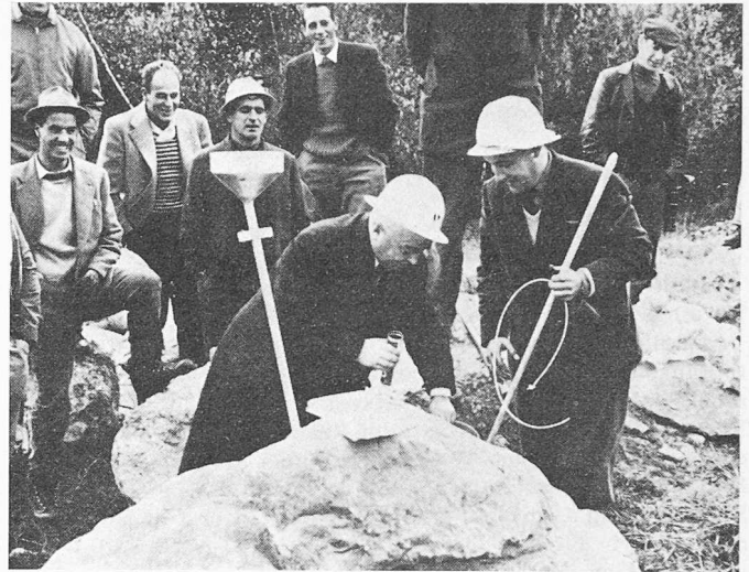
Bild 2. Vorführung über die Anwendung von Schwarzpulver bei Steinsprengungen
