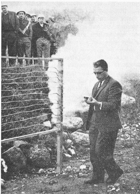
Bild 4. Vorführung verschiedener Zündschemas. Linear-, Radial- und Kreiszündung, doppelte und kombinierte Zündung
