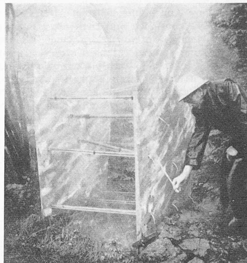
Bild 7. Ausbildungskurs für Tiefbautechniker; Zündübungen an der Stollenattrappe unter Verwendung der Kontrollsehnur
