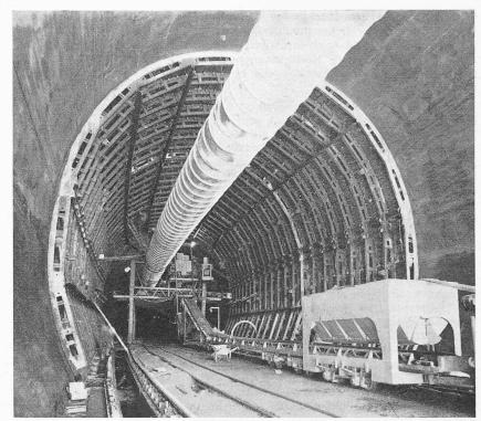
Bild 16. Betonieranlage mit Taschenwagen und Entnahmeband
