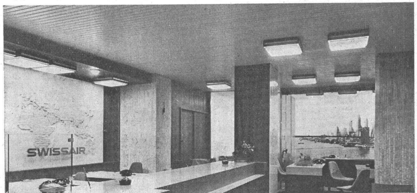
demontierbare Metalldeckenpaneele, hier als Decke für Akustik und Ventilation in einem Reisebüro
