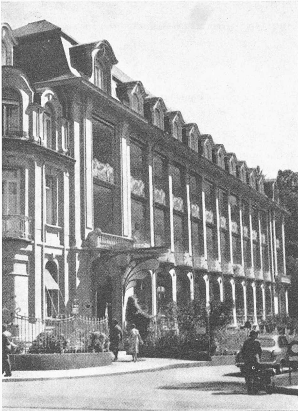
Bild 2. Südfassade des Viktoriaspitals in Bern
