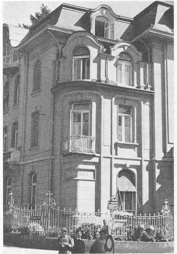
Bild 3. Uebergang von der Süd- zur Westfassade
