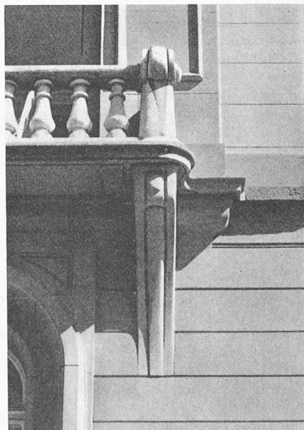
Bild 16. Balkonkonsole der Westfassade
