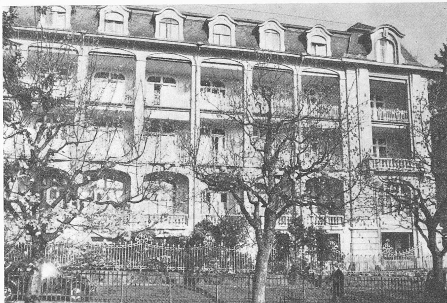
Bild 14. Südfassade des Viktoriaspitals in Bern
