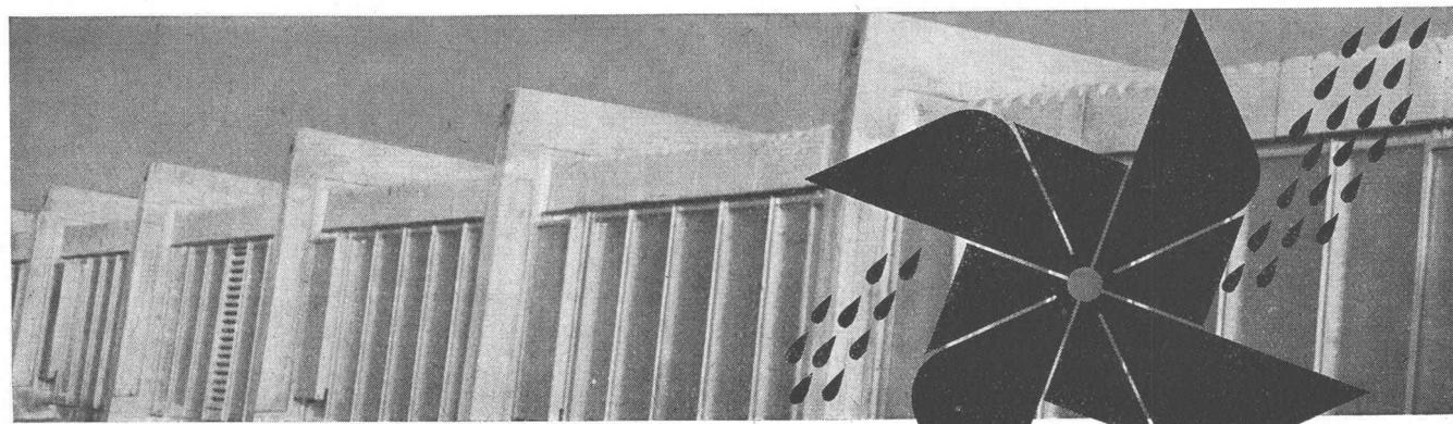
Unser kittloses System mit horizontaler Verschraubung gewährleistet spannungsfreie Fassung der Gläser und dauerhafte Dichtigkeit.
