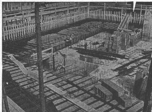
**ROBUR Schilfrohrzellen für Betondecken**
