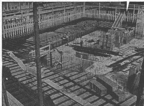
**ROBUR Schilfrohrzellen für Betondecken**
