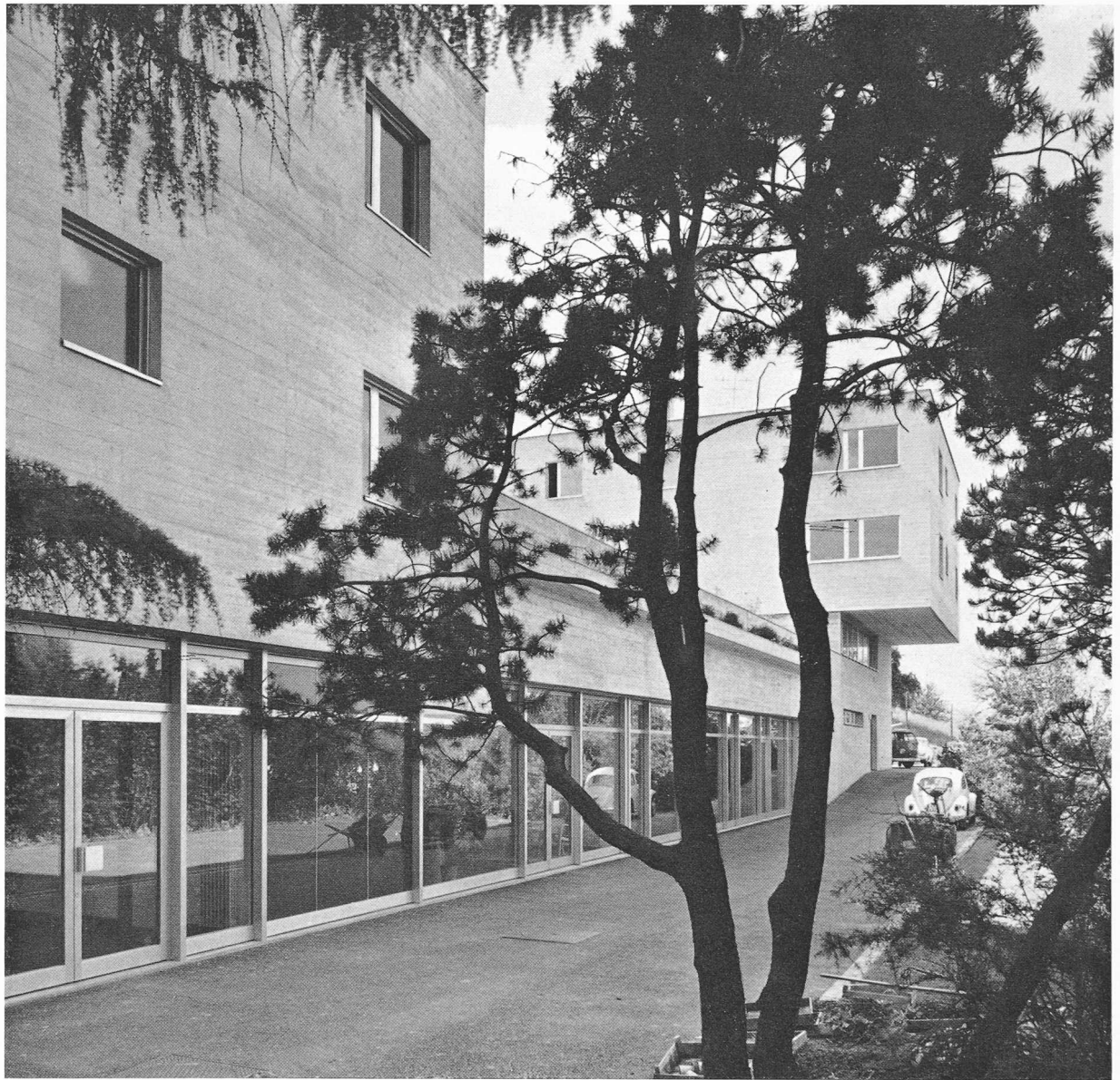
Nervensanatorium in Kilchberg ZH. Ostansicht (Seeseite) der Patientenhäuser E (im Vordergrund) und F mit eingeschossigem Verbindungstrakt (Saalbau)
