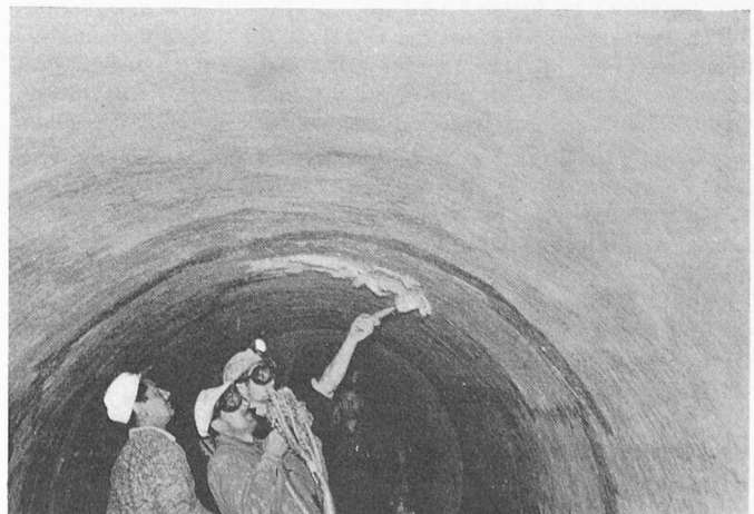
Bild 19. Beschichtung mit glasfaserarmiertem Polyester im Stollenscheitel
