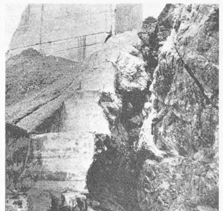
Bild 8. Rechte Talseite. Zwischen Mauer und Fels ist eine breite Kluft entstanden, die Mauer hat sich vom Fels gelöst und talwärts verschoben
