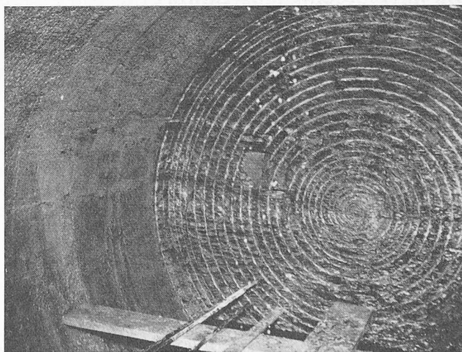
Bild 7. Brust und Parament eines mit dem Maschinen-Modell 131 — ausgerüstet mit Rollschneiden — vorgetriebenen Stollens
