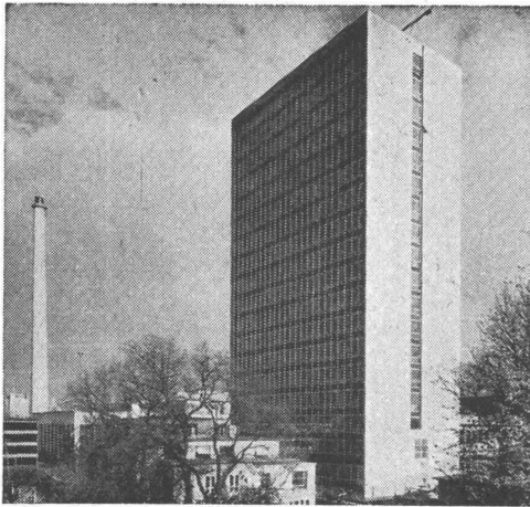
Im Hochbau für hohe Festigkeiten
