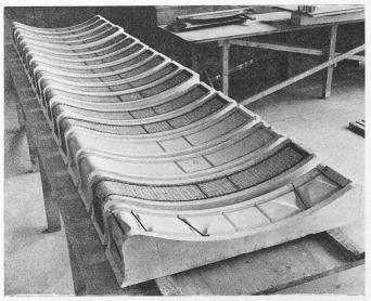
Bild 13. Zentrallager des VSK in Wangen b. Olten. Uebersicht über die «Schalungen» für die Herstellung der vorfabrizierten Elemente im Masstab 1:10 mit den masstabgetreu hergestellten Armierungsund Spannkabelverankerungen (vgl. SBZ 1962, H. 50 und RILEM 1962 Nr. 10).
