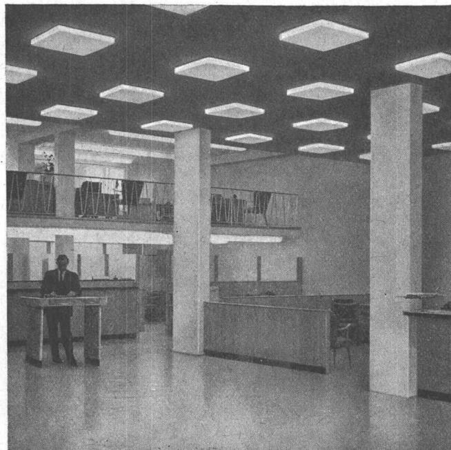
Größen der Deckenplatten. Die flache Konstruktion gewährleistet die Montage auch bei geringer Einbautiefe. Unterschiedliche Abdeckwanne und Formen, die sich auch zu Lichtbändern und Feldern zusammensetzen lassen, ermöglichen eine variable Gestaltung. Zur Erleichterung der Montage werden Befestigungsteile
