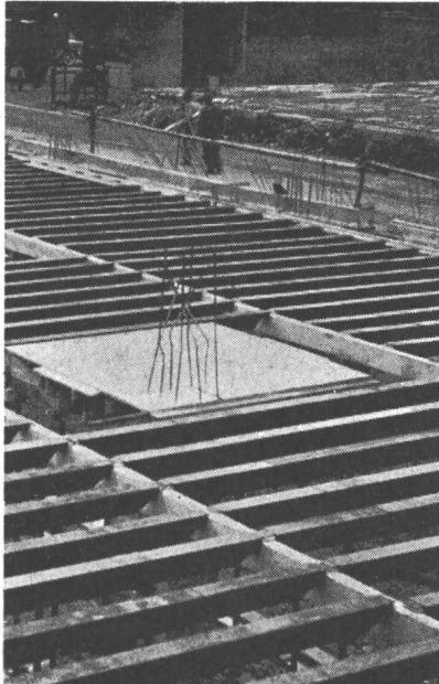
Für vollkommen ebene Decken Rückziehbare Auflagezungen Breite Auflagefläche Leicht verstellbar Spart Abstützungen Lange Lebensdauer
