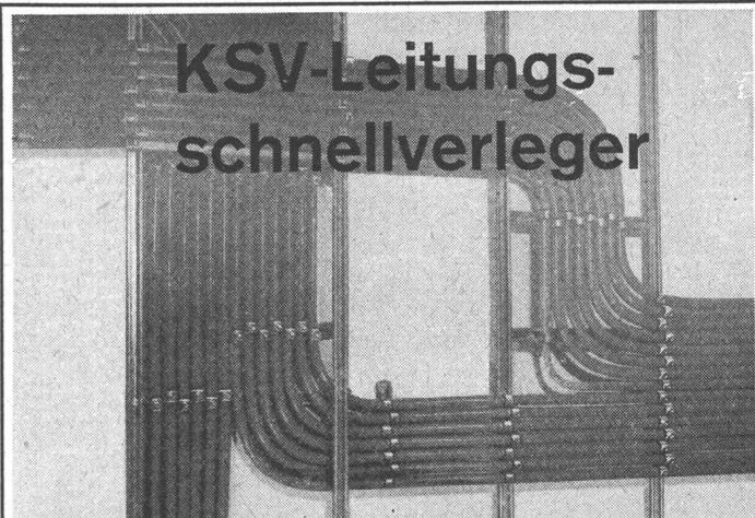
KSV-Leitungsschnellverleger besitzen einen doppelten Korrosionsschutz, der sich bei Montagen im Freien oder in Untertagbauten besonders gut bewährt hat.
