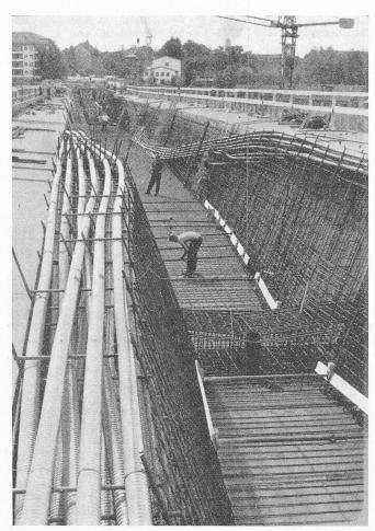
Armierung und Vorspannkabel im Bereich des Mittelpfeilers
