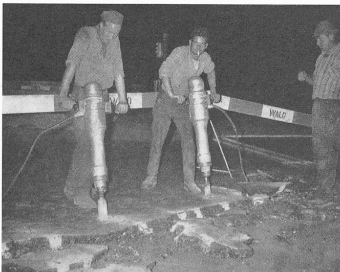
Bild 11. Nacharbeiten mit Elektrohammer
