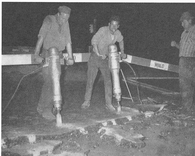
Bild 11. Nacharbeiten mit Elektrohammer
