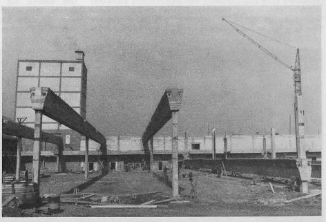
Bild 4. Hebevorgang für durchlaufende Träger
