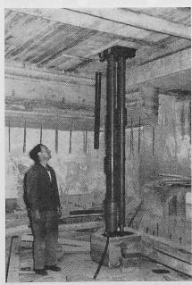
Bild 3. Einbau einer Luftschutzdecke in einem bestehenden Keller
