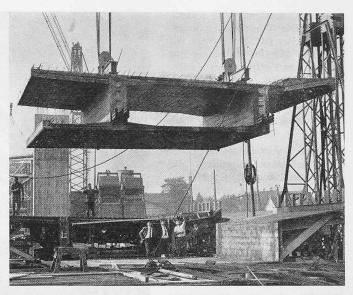
Bild 5. Montage eines vorgefertigten Fahrbahnelementes
