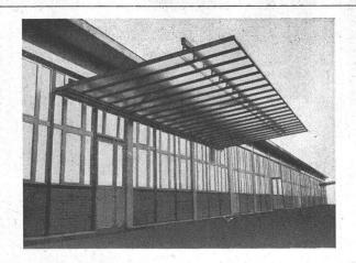
Glasvordächer in kittloser Konstruktion System WEMA
