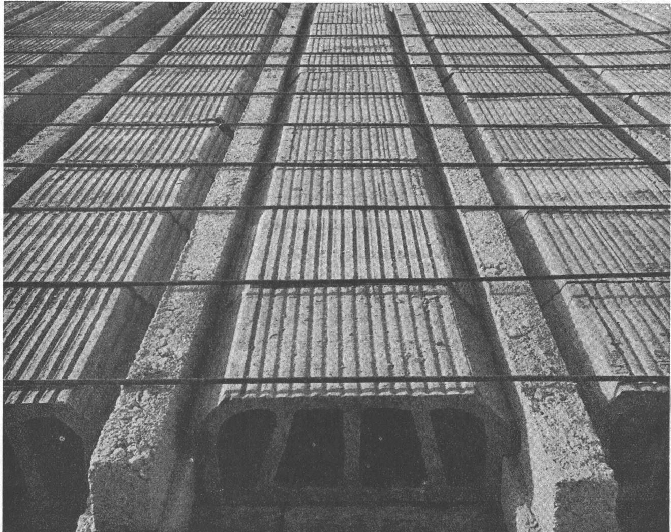
Norma- und Ottiker-Betonbalkendecken verkürzen die Bauzeit und helfen qualifizierte Arbeitskräfte sparen.
