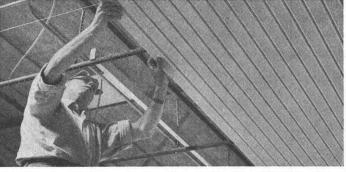
DAMPA Metalldeckenpaneele, demontierbar in Akustik- und Ventilationsdecken
