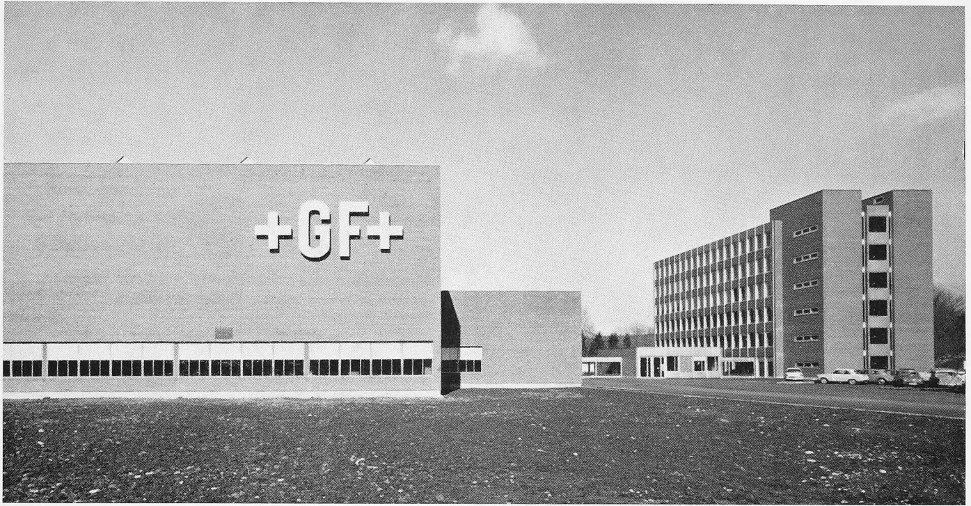
Ansicht aus Süden, links Längshalle, rechts Bürogebäude
