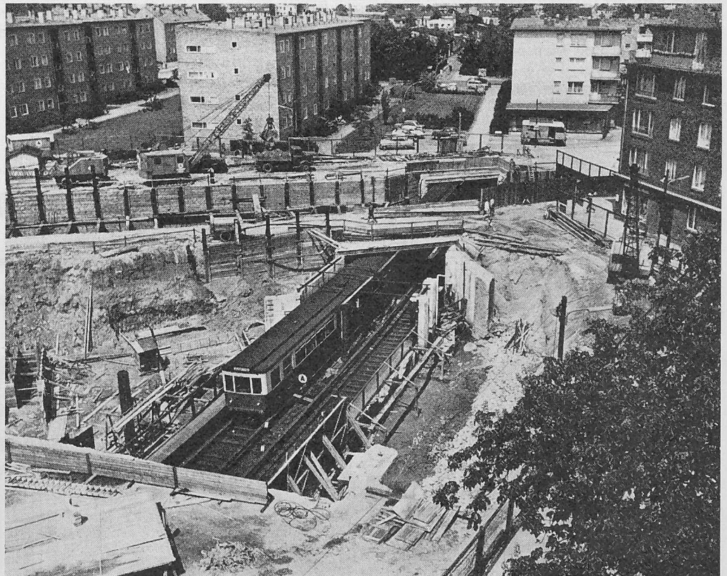
Bild 10. Baugrube für Kreuzung zweier U-Bahn-Strecken, Lübecker Strasse
