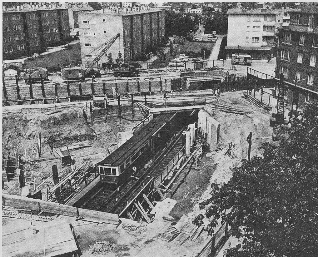
Bild 10. Baugrube für Kreuzung zweier U-Bahn-Strecken, Lübecker Strasse
