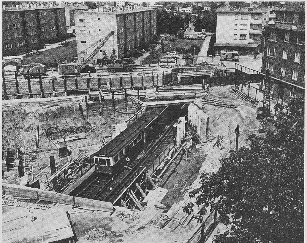
Bild 10. Baugrube für Kreuzung zweier U-Bahn-Strecken, Lübecker Strasse
