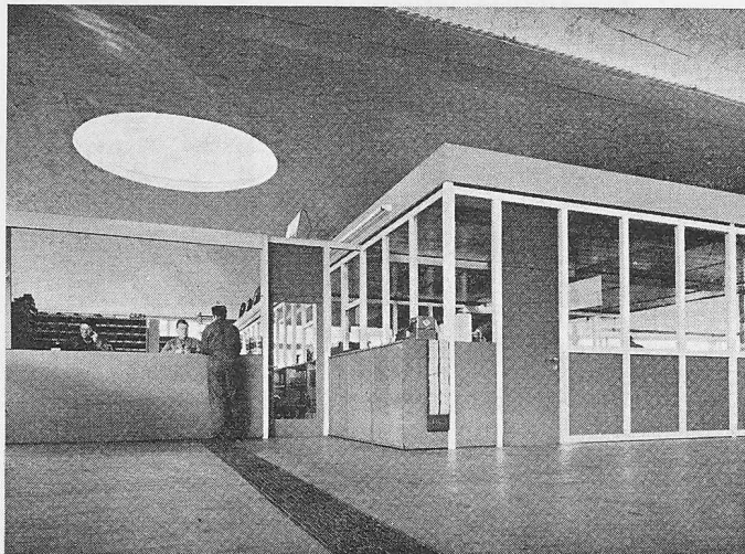
Materialausgabe, Blick von der Werkstatt gegen das Lager. Rechts der frei unter die Kuppel gestellte Bürotrakt. Staubdecke aus Profilitglas
