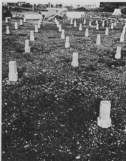
Bild 7, Pfahlköpfe nach Versetzen der Pfähle
