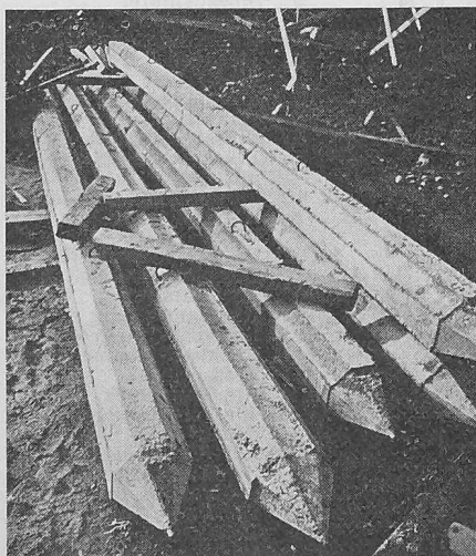
Bild 10. Pfähle aus armiertem Beton
