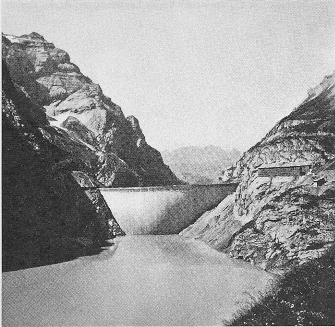
Das Staubecken Limmern anfangs August 1962. Rechts oberhalb der Mauer die Arbeiterunterkunft. Foto Schönwetter, Glarus
