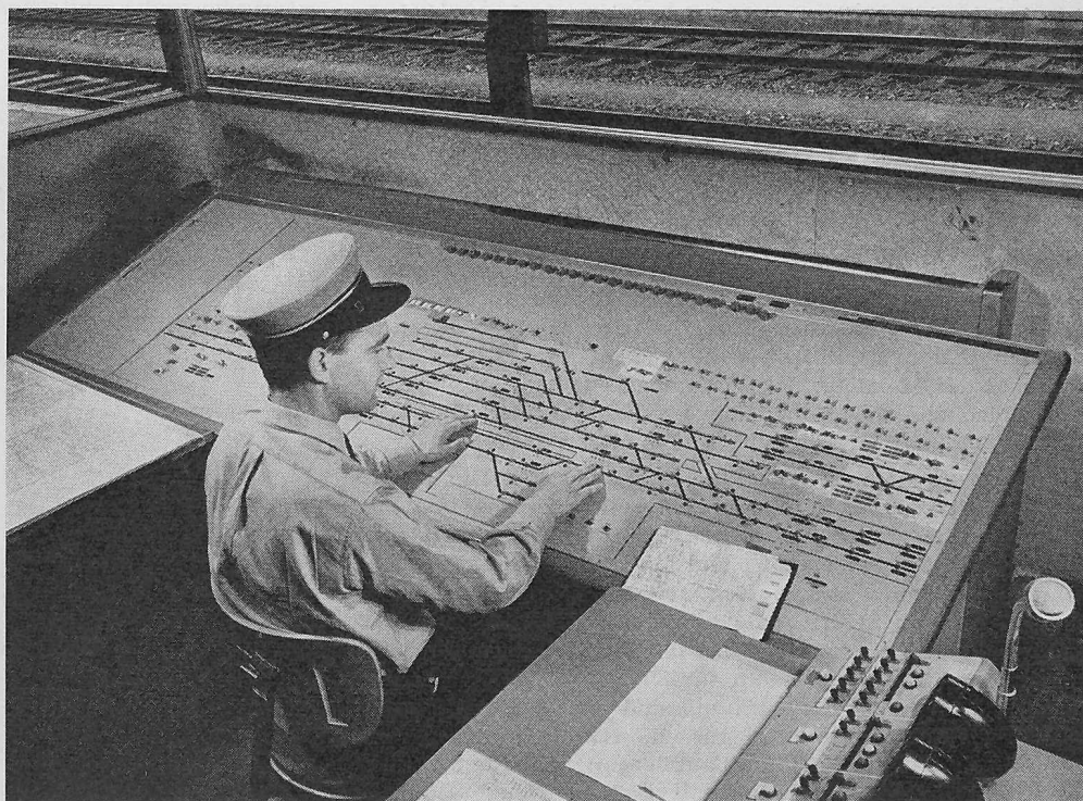
Bild 7. Das Domino-Bedienungspult, Bauart Integra, mit den Meldungen der Blockabschnitte im Tunnel und der Tunnelstation
