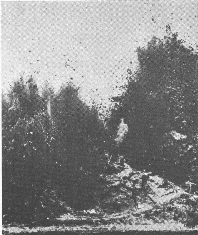
Die neue Überlagerungs-Bohrmethode zum Bohren und Sprengen von Fels unter der Erde und unter Wasser ist einfacher, billiger und vielseitiger als alle bisher angewendeten Methoden. Das Bohren erfolgt mit schweren Atlas Copco-Bohrhämtern mit separater Rotation. In jedem Stadium der Bohrung können Bodenproben entnommen werden.
