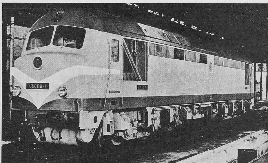
Bild 17. Lokomotive von 2400 PS mit zwei Freikolben-Gruppen
