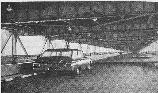
Bild 4. Untere Fahrbahn roh fertig (Oktober 1961)
