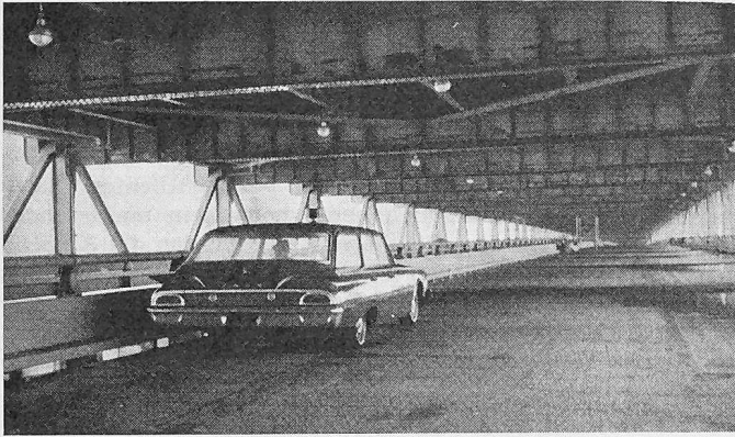
Bild 4. Untere Fahrbahn roh fertig (Oktober 1961)
