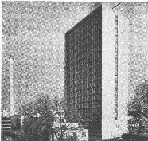
Im Hochbau für hohe Festigkeiten
