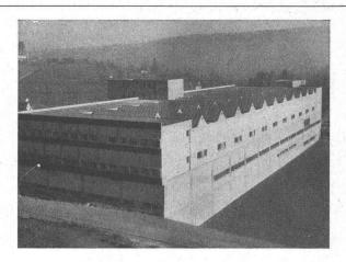
Sattelglasdächer in kittloser Konstruktion System WEMA
