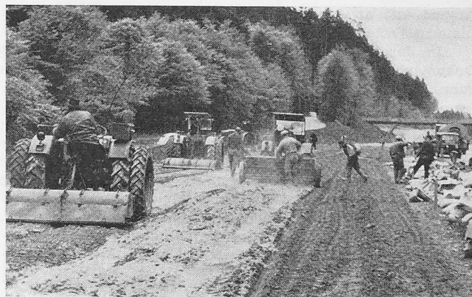
Bild 5. Nationalstrasse Nr. 1 Bern — Zürich. Einbau einer mit Zement stabilisierten Schicht beim Grauholz (nördlich von Bern). Rechts aufgelockertes Fundationsmaterial, in der Mitte Verteilen des Zementes, links Mischen
