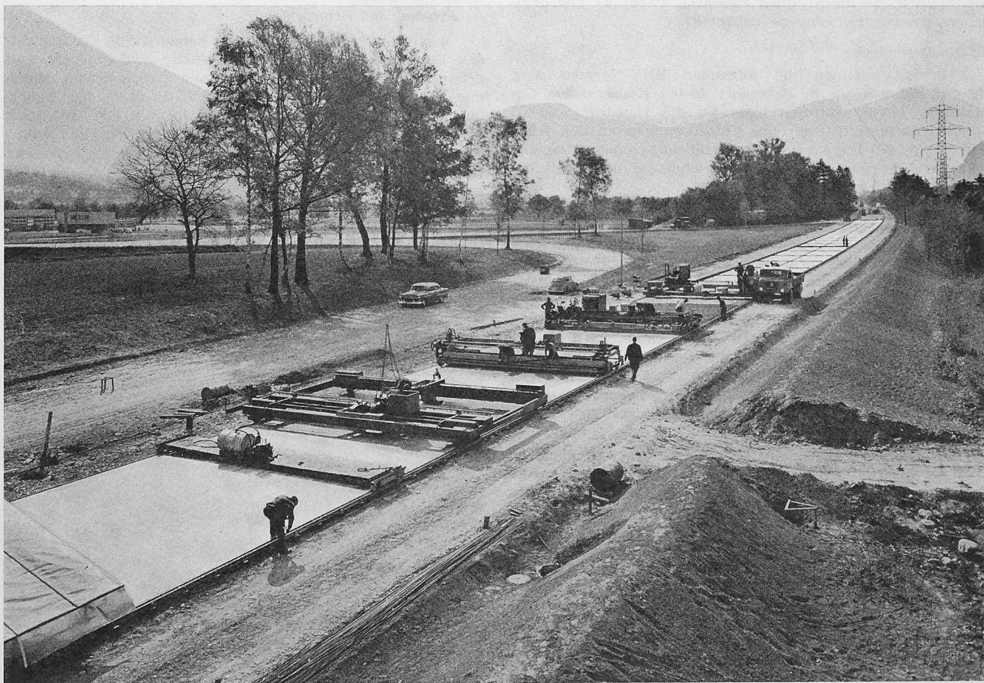
Bild 10. Nationalstrasse Nr. 13 beim Anschlussbauwerk Maienfeld, Blick gegen Landquart. Von rechts nach links d. h. von hinten nach vorn im Bilde: auf Plastikfolie verlegte untere Fugeneinlagen (Welleternitstreifen), Lastwagen beim Beladen des Betonverteilers, Betonstrassenfertiger, Fugenvibriergerät, Längsfertiger, Steg zum Aufspritzen des Schutzfilmes (curing), Schutzdach
