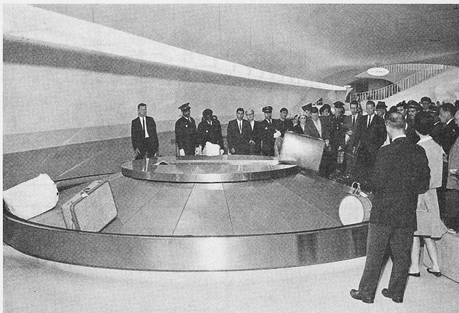
Bild 4. Drehtisch für die Abgabe des Gepäcks an die Passagiere im Flughafen New York Idlewild. Photo TWA
