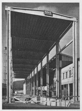
Bild 2. Fertig eingedeckte Hallenkonstruktion aus vorfabrizierten Rippenplatten. Abmessungen der Halle: Länge  $124\,\mathrm{m}$ , Breite  $16\,\mathrm{m}$ , Höhe  $20\,\mathrm{m}$
