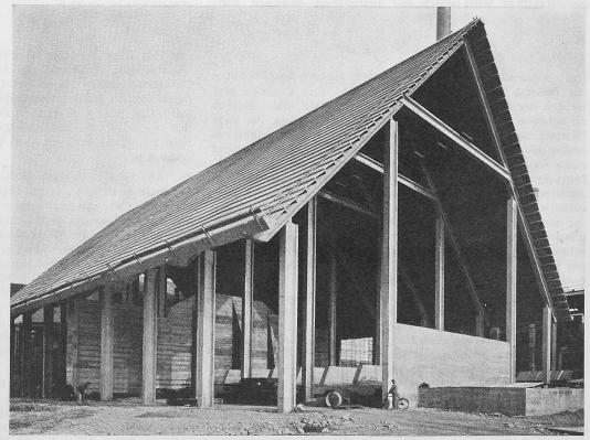
Bild 6. Fertig eingedeckte Rohmaterialhalle von ca. 30 m Höhe (vgl. Velofahrer). Im Innern erkennt man die Trennwand zwischen dem Kalk- und Tonlager, welche die gesamte Querstabilität gewährleistet
