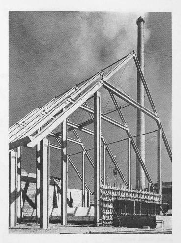
Dachplatten kehrt sich das Diagramm um. Drittens: Beim Anspannen der Kabel erfolgt nochmalige Umkehrung, bis am Schluss unter voller Schneelast am Obergurt 132 kg/cm² auftreten und an der Unterkante Spannungslosigkeit herrscht.
