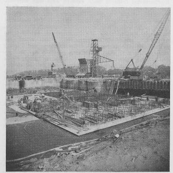
Bild 2. Fundament Brooklyn-Pylon
